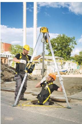
**Das Betreten und Verlassen enger Räume erfordert möglicherweise Ausrüstung für den Einstieg und zur Rückholung aus engen Räumen.** Zu ordnungsgemäßen Absturzsicherungssystemen für Arbeiter gehören ein Anschlag (z. B. ein Dreibein), ein Auffanggurt und Verbindungsmittel (z. B. ein einziehbares Rettungsseil, eine Winde oder ein Rettungsgerät).
